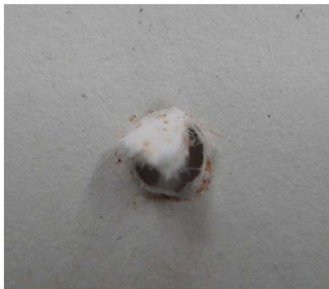
写真7 穴の部分の紙がめくれている
