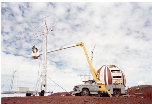
写真3 鉄塔作業をする Bruce
