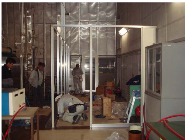
写真1 見学用のガラス室の敷設工事
