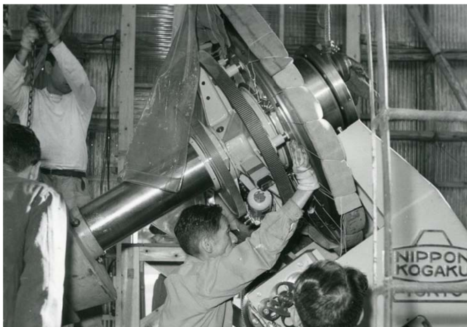
写真7 架台部に赤経軸の組み込み
