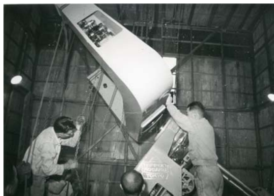
写真5 フォークに中央鏡筒部の取り付け 写真6 赤経軸にフォークの取り付け
