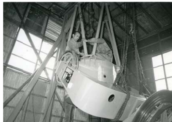
写真 4 セルリエトラスの取り付け
