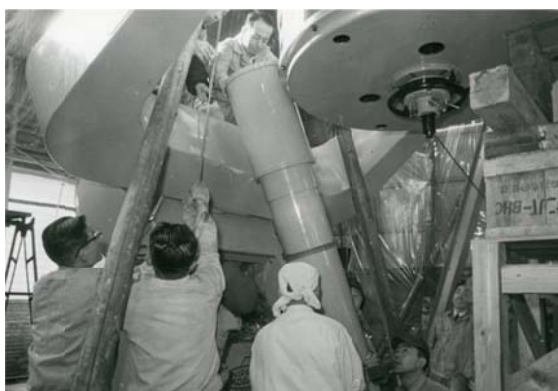
写真 3 案内望遠鏡の取り付け
