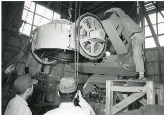
写真5 フォークに中央鏡筒部の取り付け 写真6 赤経軸にフォークの取り付け
