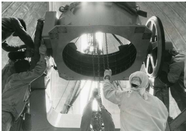
写真 5 センターセクションの取付
