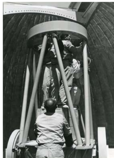
写真 6 セルリエトラス取付
