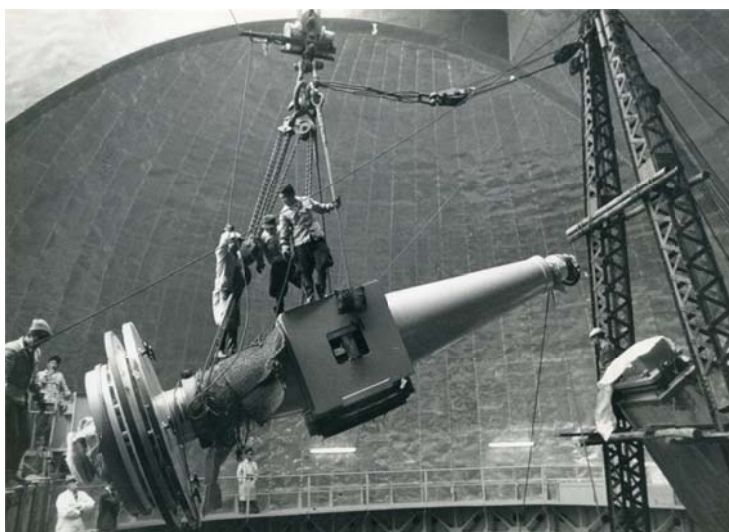
写真 6 極軸の組み付け
