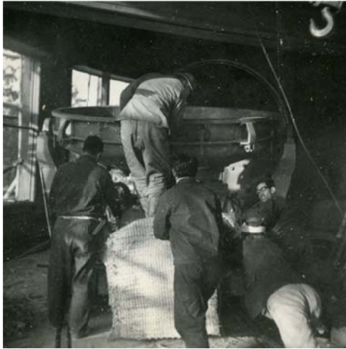
写真2 蒸着装置工事1
