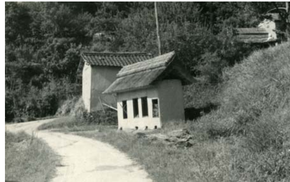
写真 17 地頭上字山ノ奥池堤下
