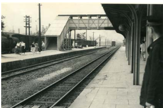
写真 1 山陽本線鴨方駅ホーム
