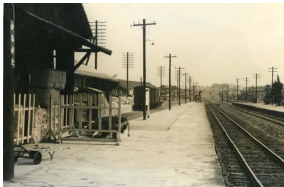
写真 2 鴨方駅ホーム 上り線
