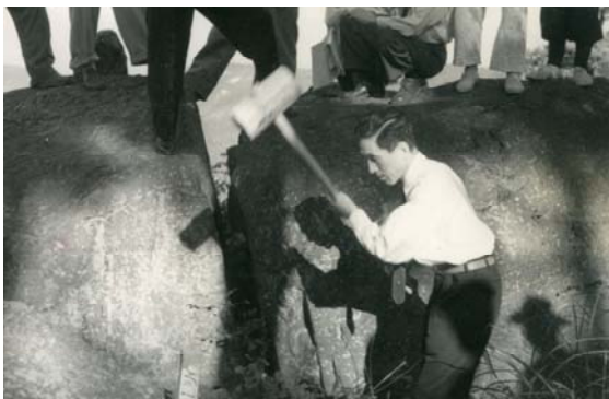
写真 14 境界線への杭打ち
