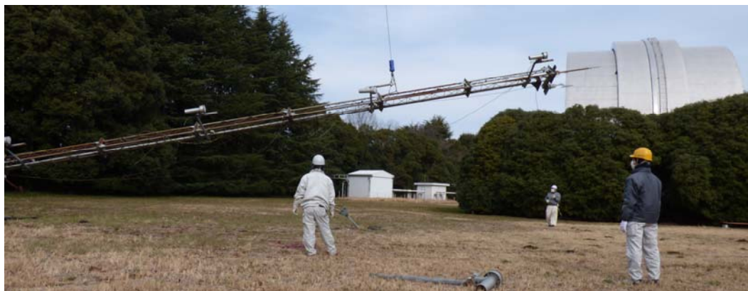
写真7 地上近くまで倒された鉄塔
