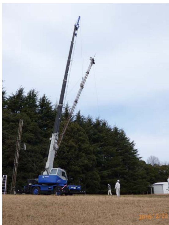
写真 6 傾けられ倒される鉄塔
