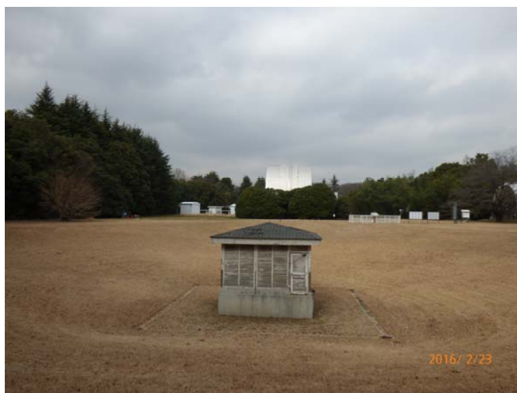
写真9 鉄塔撤去後 鉄塔が消えた
