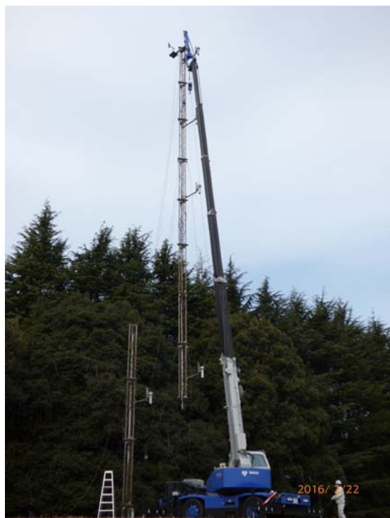
写真 5 途中で切り離された鉄塔
