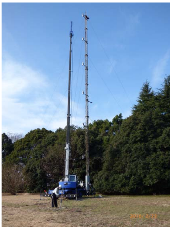
写真 2 鉄塔とレッカー
