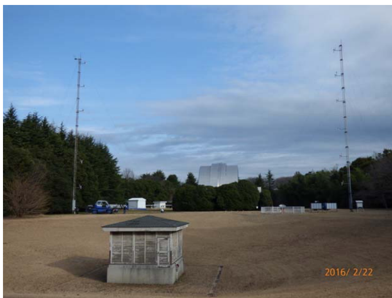
写真1 鉄塔撤去前 南から見た鉄塔
