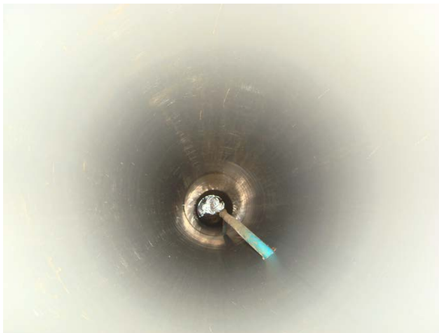
写真 5 水抜き井戸に排水しているホース
