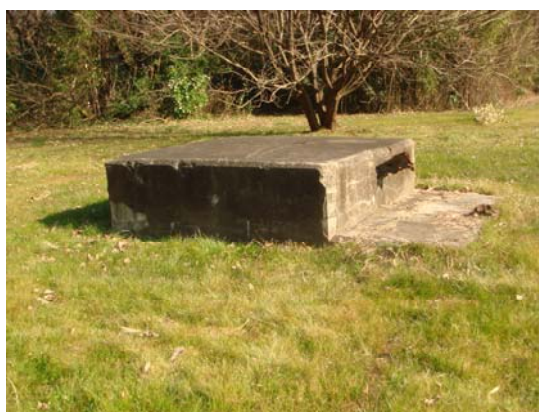
写真4 ①鉄塔跡の4個のステーの基礎コンクリート
