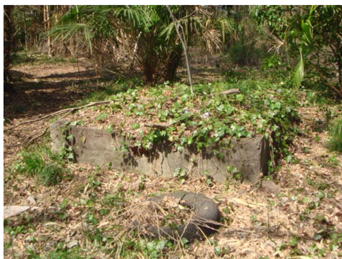
写真5 基線尺倉庫東のコンクリート基礎
