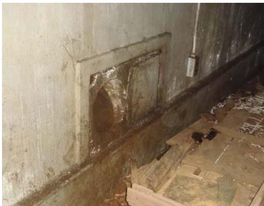
写真 2 壁面の通風孔
