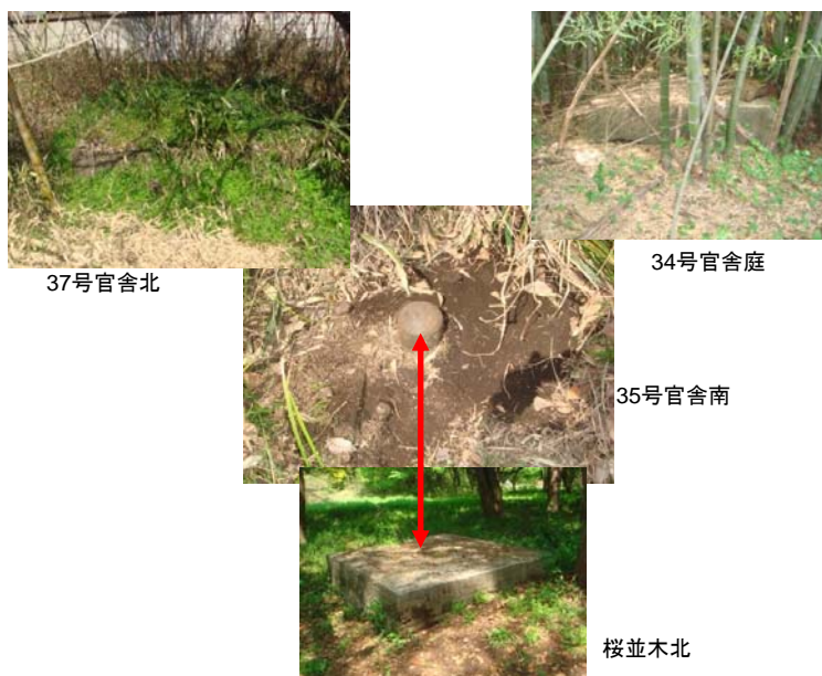
図 1(写真) 写真 1 の④の鉄塔の基礎とステーのコンクリート基礎
