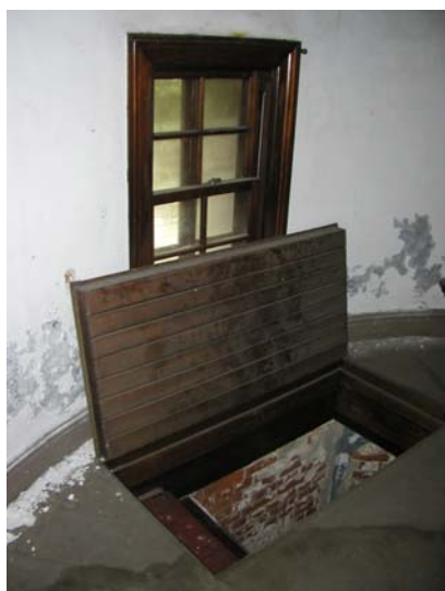
写真6 観測床のハッチ
