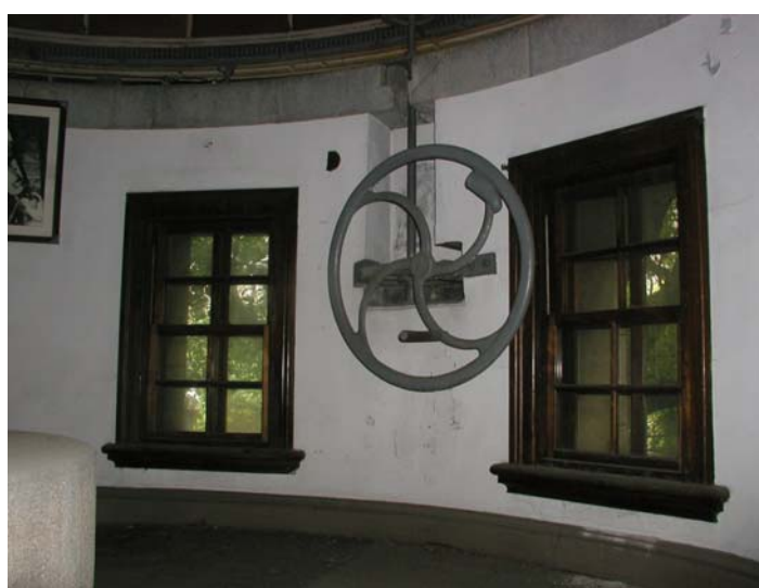
写真7 ドーム回転用の手動ハンドル
