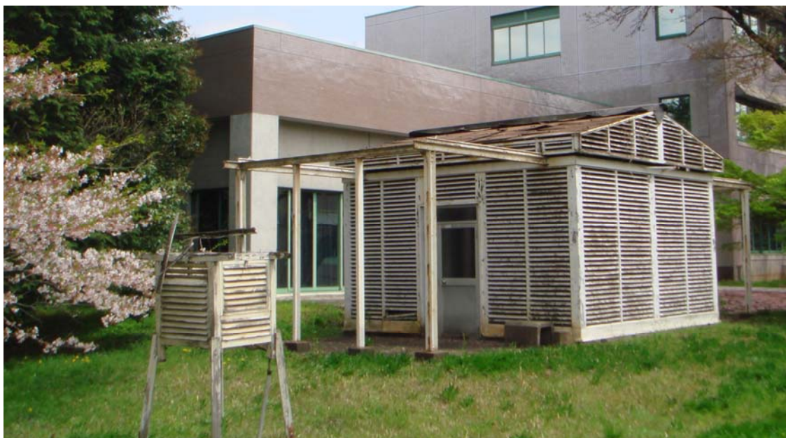
写真4 屋根板が吹き飛んだPZT建屋の屋根
