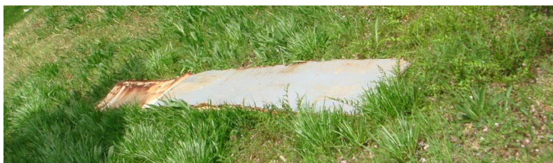
写真6 吹き飛ばされた屋根板
