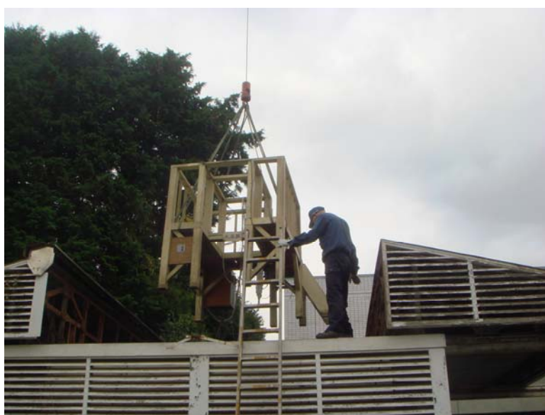
写真 3 PZT 移設の様子
