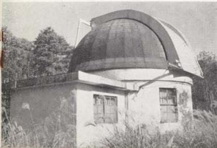
写真 13 30cm 赤道儀望遠鏡とドーム (マルコビッチカメラが搭載されている)
