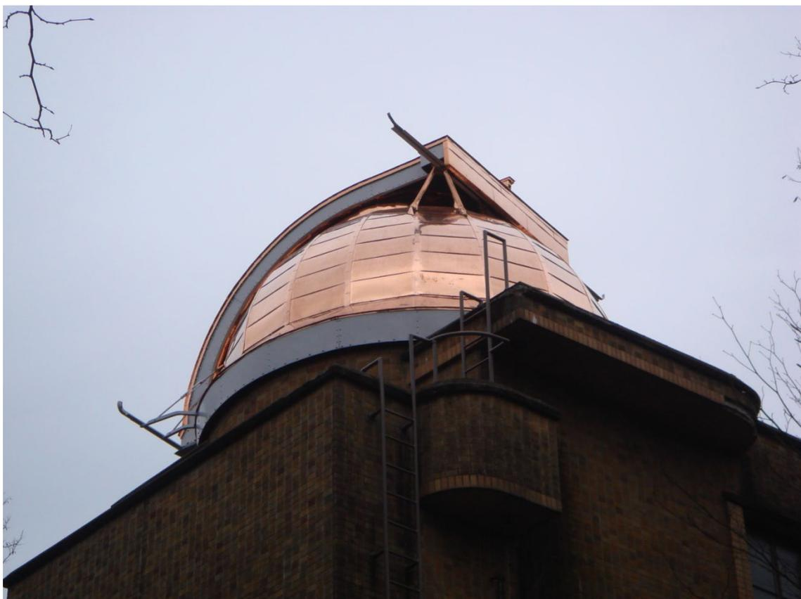
写真7 雨漏り修理で葺きかえられ金ぴかに輝くドーム
