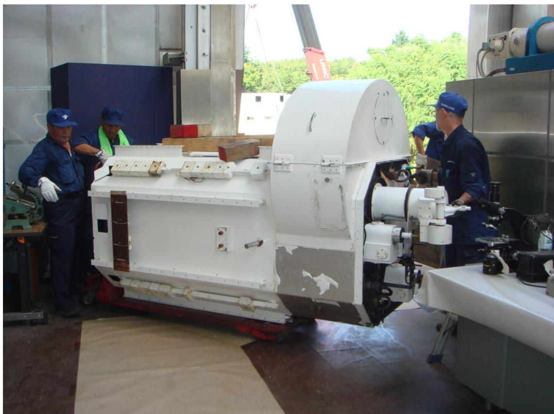
写真2 天文機器資料館への望遠鏡部分の吊り込み作業
