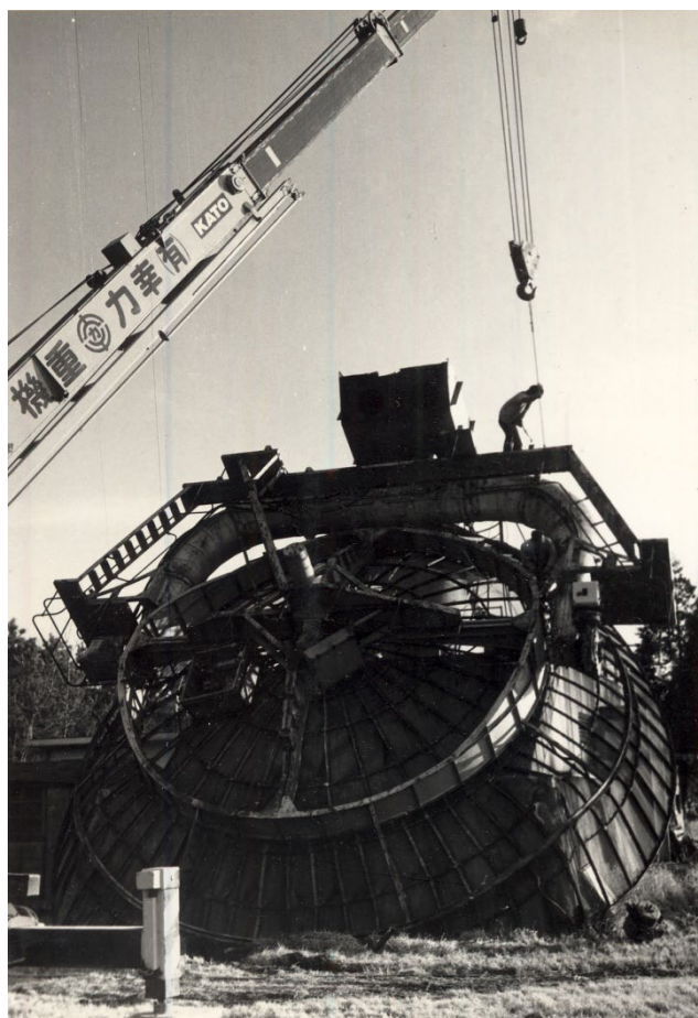
写真2 クレーンによる10mパラボラアンテナ解体
