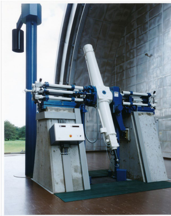
写真2 ピアがコンクリートのまま
