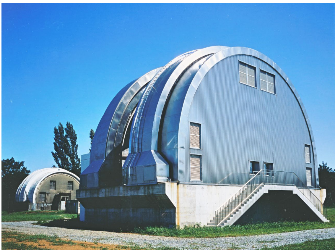
写真1 完成当時の自動光電子午環棟
