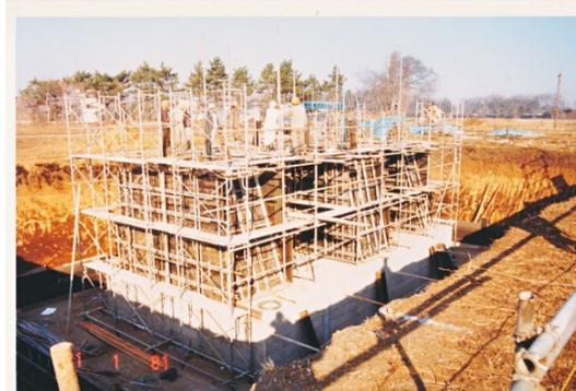
写真 11 写真 8 の上にピアの基盤
