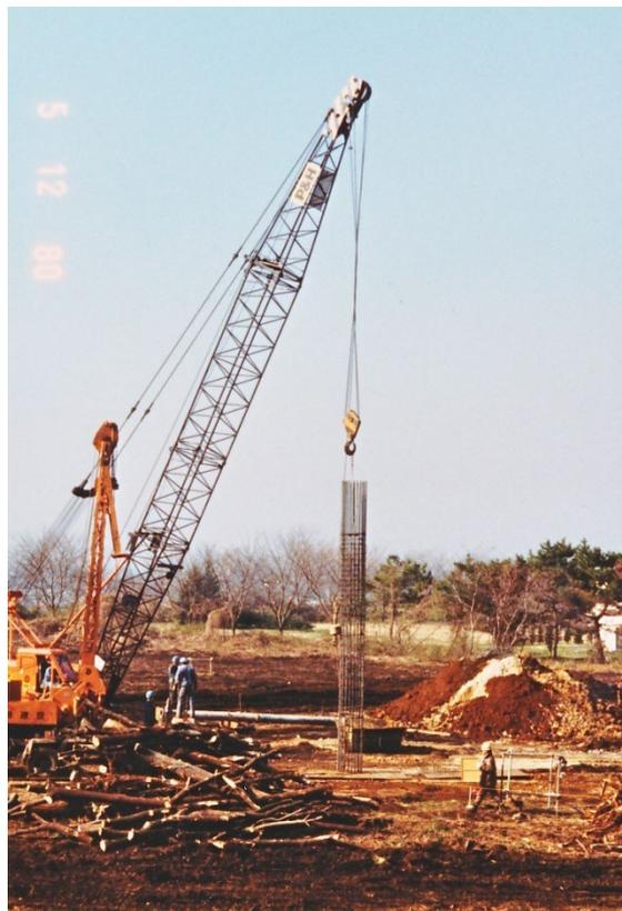
写真6 組まれた鉄筋が下ろされている
