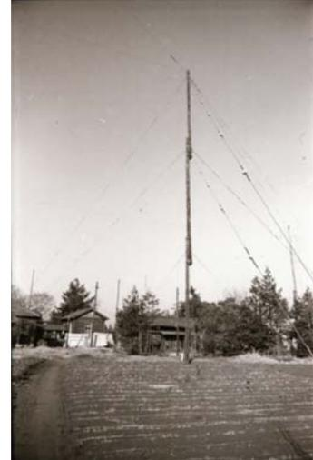
写真8 木製電柱アンテナ
