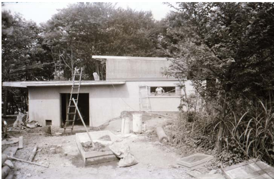
写真2 建設中のシュミット観測室
