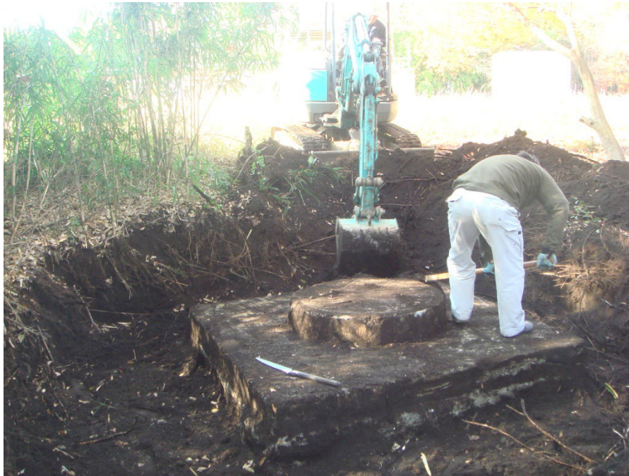
写真1 60m 鉄塔の基礎の発掘作業
