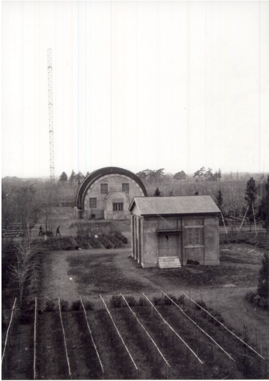
写真7 ゴーチエ子午環の西にそびえる 60m 鉄塔④
