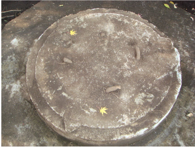
写真3 円形のコンクリートの上に出たアンカーボルト
