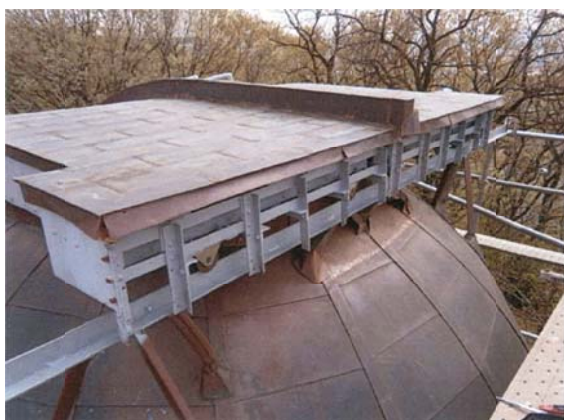
写真15 新しいレールと車輪
