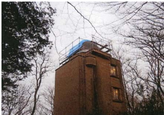
写真11 養生されたスリット部
