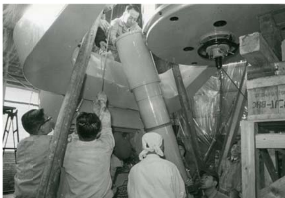
写真 3 案内望遠鏡の取り付け
