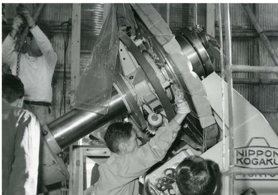
写真 7 架台部に赤経軸の組み込み
