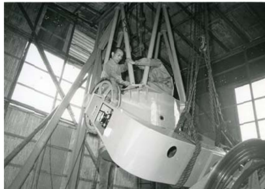
写真 4 セルリエトラスの取り付け
