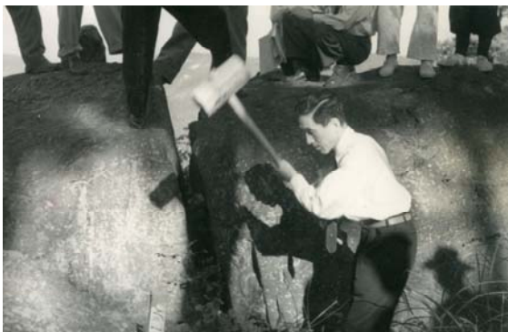
写真 14 境界線への杭打ち
