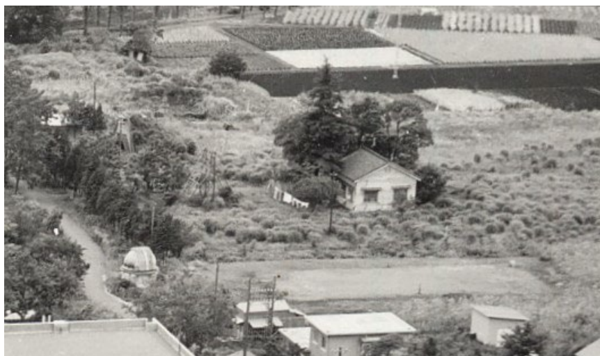
写真 1 東大地震研三鷹分室の建物
