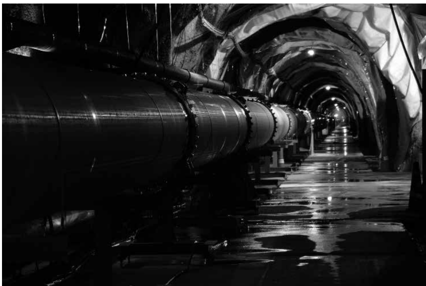
図1. KAGRA建設経過：神岡鉱山内においてアームダクトが設置される間、三鷹のTAMA真空槽の一つでは防振システム最初のフル・プロトタイプ試験が行われている。
